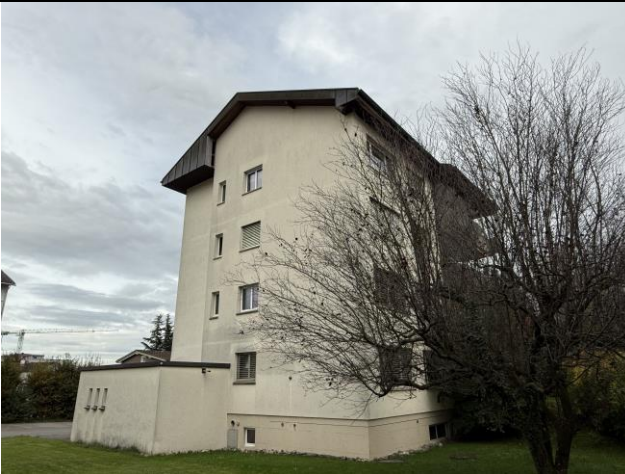
Ansicht Fassade Süd-West
